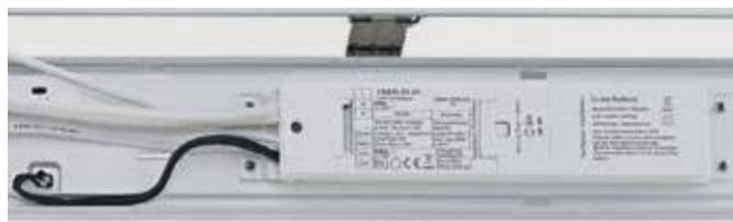
Mit automatischem monatlichen und jährlichen Selbsttest. Diese Funktion überwacht fortwährend den Zustand der Leuchte und führt regelmäßige Tests durch, um sicherzustellen, dass alle Komponenten ordnungsgemäß funktionieren. Eine Status-LED informiert kontinuierlich über den Zustand des Notlichtsets. Dazu gehört die Überprüfung des Akkus, der LED, des Treibers und der Steuerung.
